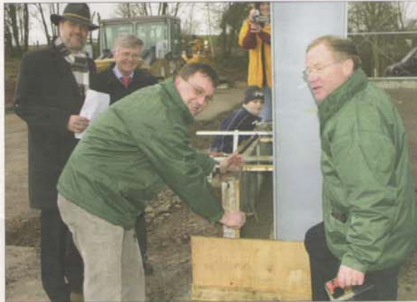
Sven und Friedrich Deppe betonieren eine Dokumentenschatulle in den Grundstein ein. Im Hintergrund Architekt Hermann-Josef Hupe und Bad Lauterbergs Bürgermeister Otto Matzenauer.
